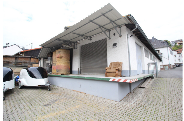
Andienung über Rampe
